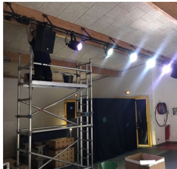
chantier d'installation du matériel d'éclairage et de sonorisation dans la salle d'activité principale
